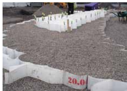
TERRAM Geozellen, 220mm x 220mm, 3m x 6m Abmessung, erste Schicht
